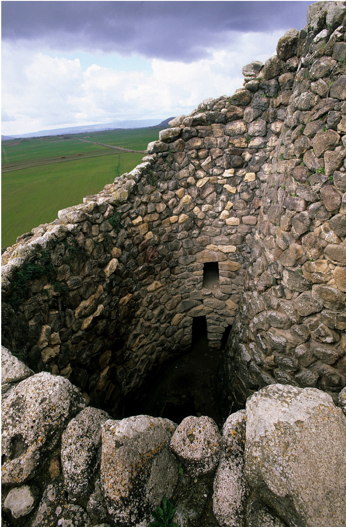
4 Muro della torre centrale di Barumini (da Sardegna Digital Library).
